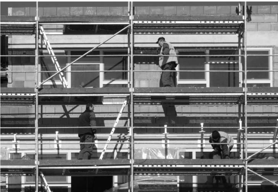
Stavba nového domova mládeže střední školy pokračuje montáží izolační vrstvy na venkovní fasádu. Práce by měly být dokončeny v srpnu, aby zde již od 1. září mohli bydlet žáci a studenti školy. Foto Karel ROM
