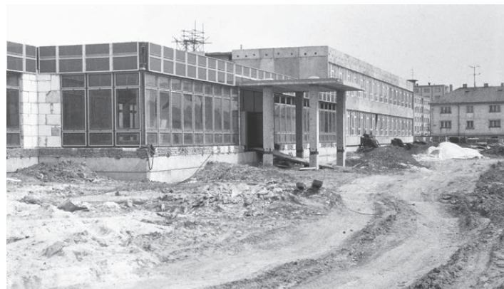
Budova nové školy před dokončením, fotoarchiv Muzea v Mariánské Týnici
