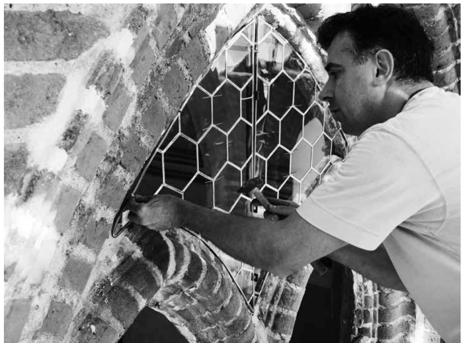
Na kostele sv. Petra a Pavla probíhá oprava fasády, restaurované vitráže byly nainstalovány zpět do oken v pátek 16. září. Foto T. Soukup
