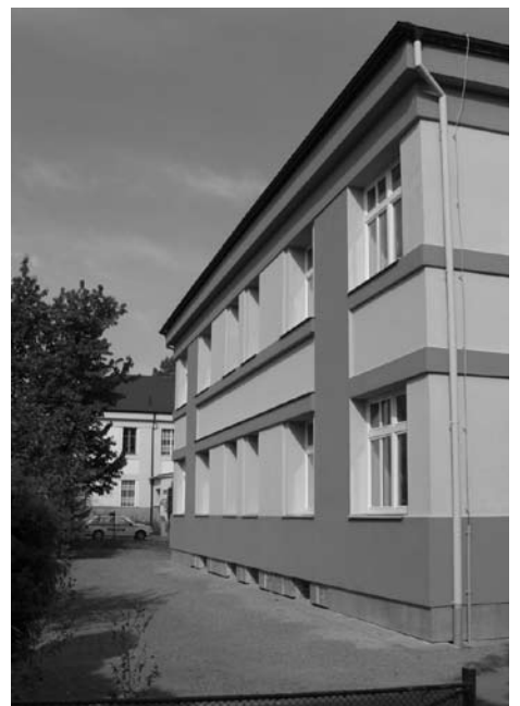
Rekonstrukce budovy základní umělecké školy včetně nové fasády je dokončena. Na akci, jejímž důvodem bylo především zateplení a úspory energie, bylo využito dotace Státního fondu životního prostředí, ze které bylo hrazeno 1,1 mil. z celkových nákladů 1,6 mil. Kč.
