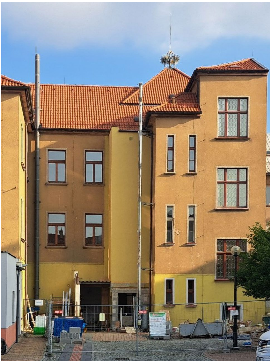
Na radnici pokračuje přístavba výtahu – v šachtě již byly namontovány kolejnice pro vedení kabiny. Dále se pracuje mj. na úpravách interiéru budovy včetně výměny oken. Akce je podpořena dotačním titulem. Foto K. Popel
