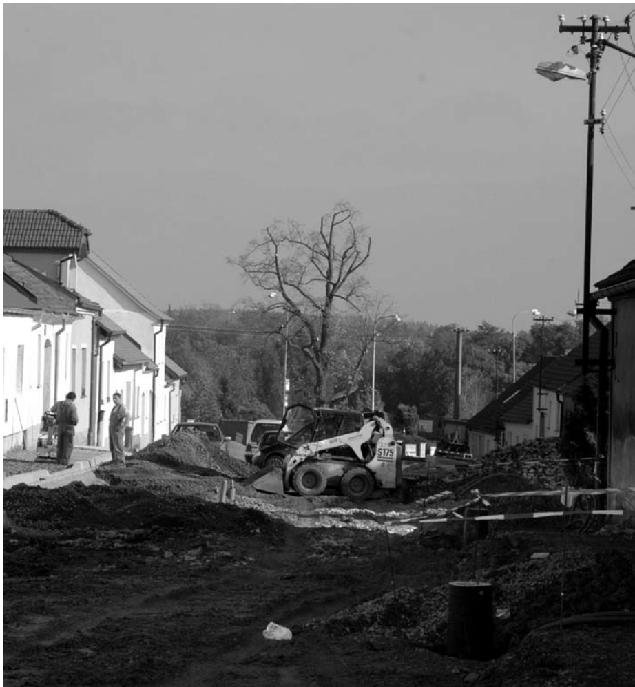
Rekonstrukce ulice Petra Bezruče se blíží do závěrečné fáze; firma EUROVIA dokončuje zakládání obrubníků a připravuje pokládku asfaltu a dlažby z betonových tvarovek
