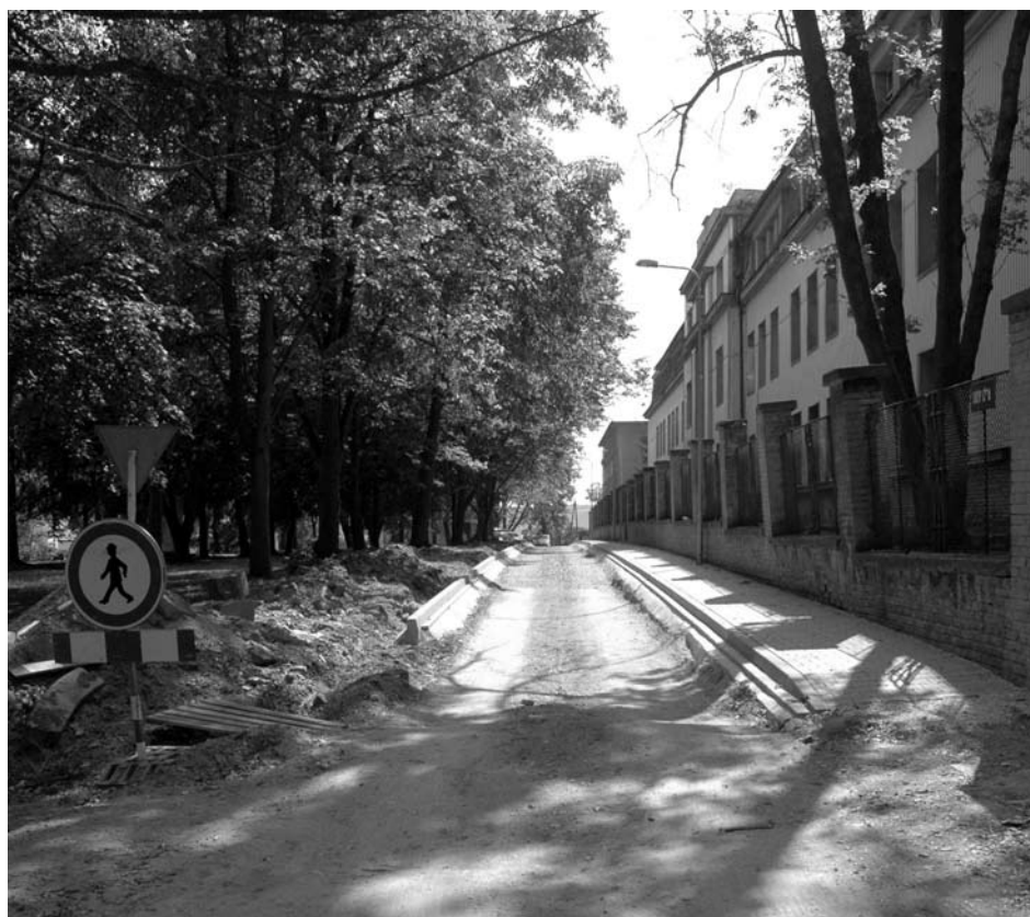
V Sadech Československé armády naplno probíhá rekonstrukce komunikací. Práce zkomplikovala skutečnost, že město velmi dlouho čekalo na konečné rozhodnutí o přidělení dotace, čímž se opozdilo zahájení stavby, konečný termín – tedy 31. srpen – se nicméně nemění. Práce v hodnotě 6,5 mil. Kč provádí firma EUROVIA CS.
