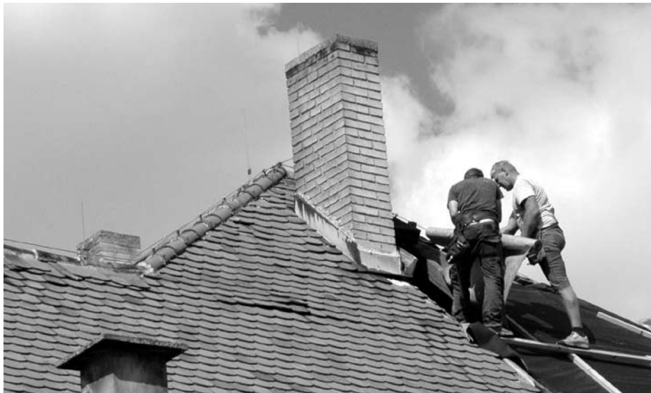
Pokrývači při práci na střeše hasičského domu v Žatecké ulici
