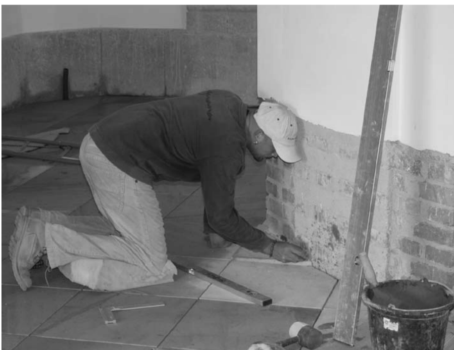
V současné době je v Mariánské Týnici dokončována dlažba pod kruchtou kostela. Hotova by měla být do tradiční zářijové pouti. Foto Karel Rom.
