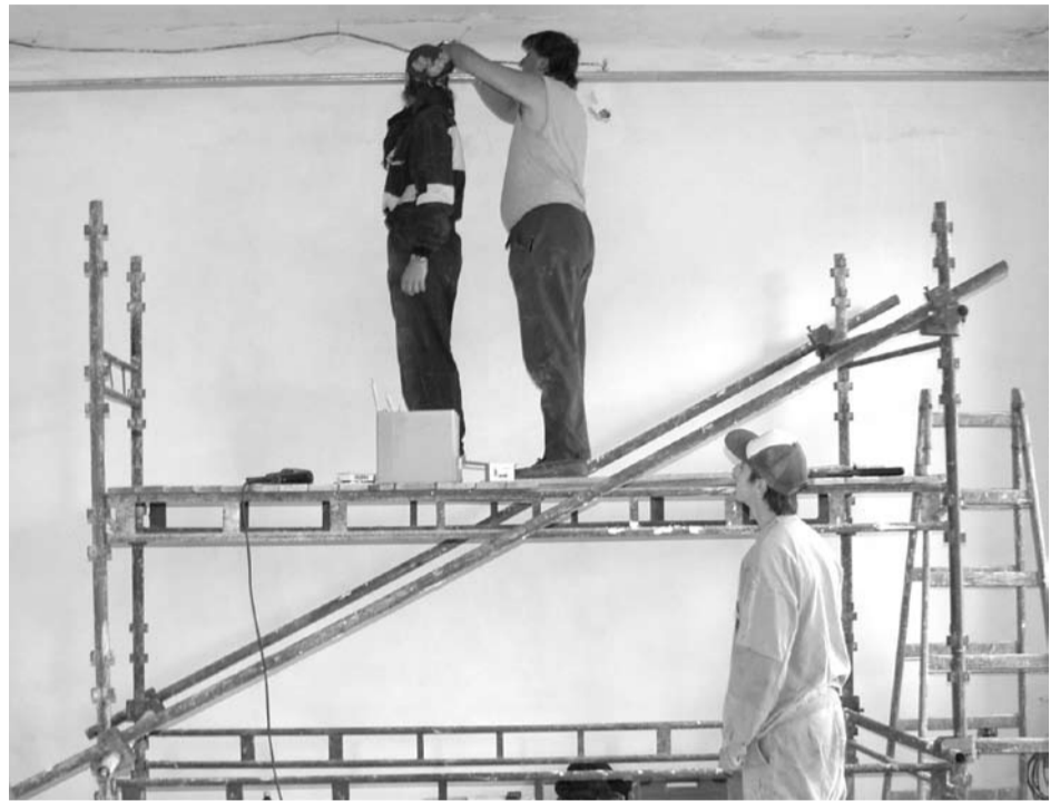
V budově radnice byla zahájena rekonstrukce zasedací síně. Vyměněny budou elektrické rozvody a osvětlení, opravena podlaha a místnost dostane nové obložení, aby byla opět důstojným místem pro zasedání orgánů města i jiné akce. Následovat bude i vymalování schodiště. Pokračuje se tak v pracích již dříve započatých, které bylo nutno zastavit v důsledku náročných úprav druhé budovy úřadu v Manětínské ulici. Budova v Markově ulici je rekonstruována postupně, tak jak to dovolí finanční situace města. Na jednorázovou generální rekonstrukci prostředky nejsou. Foto Karel Rom.
