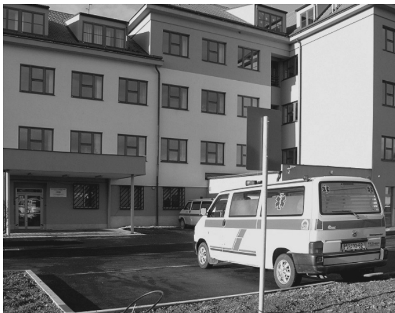
Parkoviště pro ZZS v areálu městského úřadu v Manětínské ulici je dokončeno. Chybí ještě veřejné osvětlení a vodorovné značení na parkovací ploše, které však může být provedeno pouze na suchý podklad.
