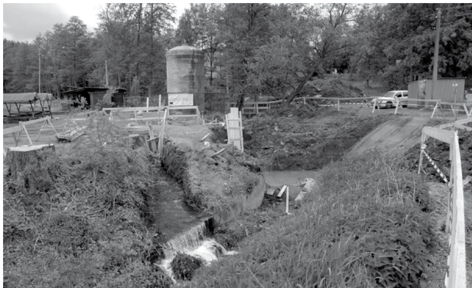
U fotbalového hřiště vzniká nový mostek přes Kralovický potok. Foto Karel ROM
