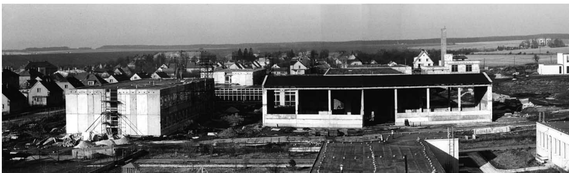
Obrázkem z průběhu stavby se ještě vracíme k příspěvku v minulém čísle, věnovanému 30. výročí otevření nového areálu Základní školy v Kralovicích.
