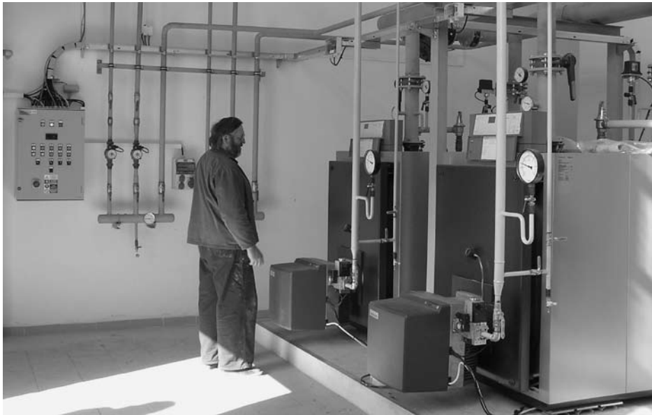
Na začátku prázdnin byla zahájena rekonstrukce kotelny v základní škole. Poslední z větších uhelných koteľen v majetku města byla přestavěna na vytápění plynem, což mimo komfortnější obsluhu přinese i výrazně nižší zatížení ovzduší škodlivými emisemi. Rekonstrukce, na kterou se městu podařilo získat finance z prostředků Evropské unie, je dokončena a kotelná je připravena na nastávající topnou sezónu. Foto ZŠ Kralovice
