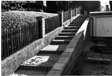
Práce na schodišti mezi Zateckou a Sadovou ulicí opět pokročily a rekonstrukce se blíží do svého závěru. Foto P. Zemanová
