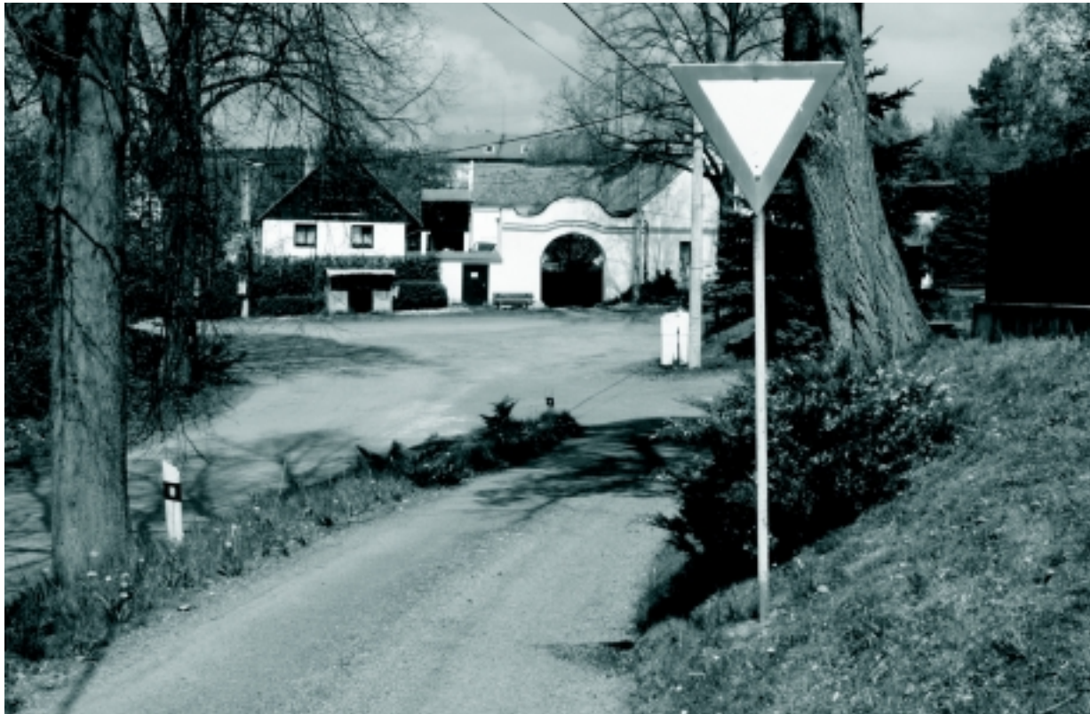
V současné době probíhá rekonstrukce místní komunikace v Řemešíně. Nový povrch si vyžádá náklady asi 300 000 Kč.
