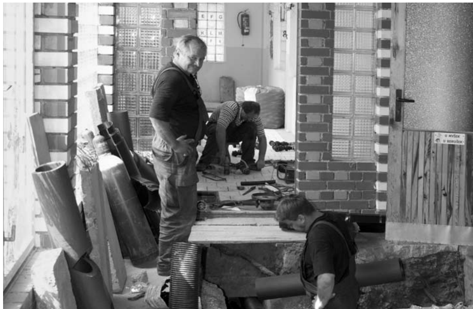
V mateřské škole probíhá rekonstrukce spojovacích chodeb (blíže na s. 1). Foto Karel ROM
