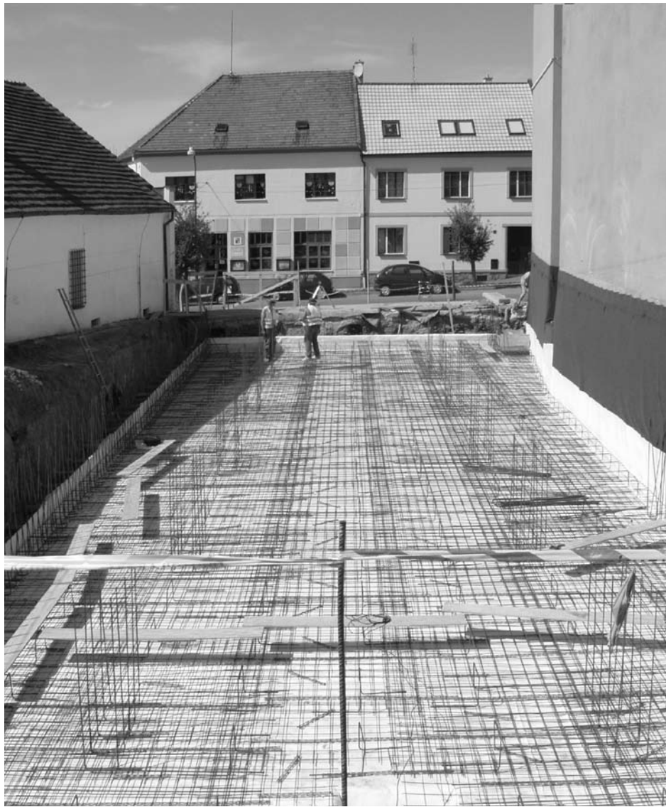
Po ukončení archeologického výzkumu zahájila firma JIPS práce na přístavbě městské knihovny
