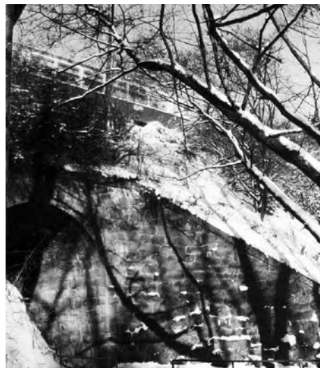
Viadukt u starého kralovického koupaliště v době, kdy po něm projížděly vlaky mířící z (a do) Mladotic. Foto K. Popel
