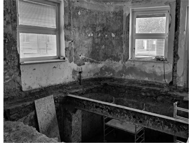
V polovině června byla zcela vybourána podlaha mezi vstupním prostorem a sklepem lidového domu. Foto K. Popel
