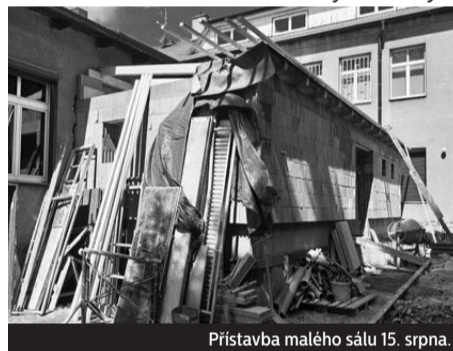
Přístavba malého sálu 15. srpna.
