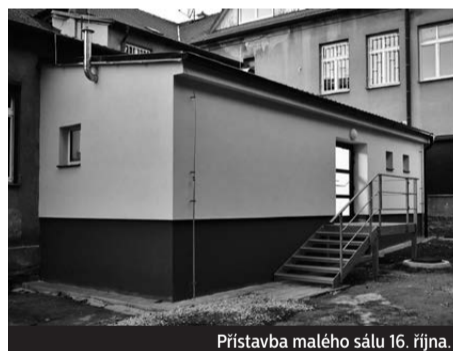
Přístavba malého sálu 16. října.
