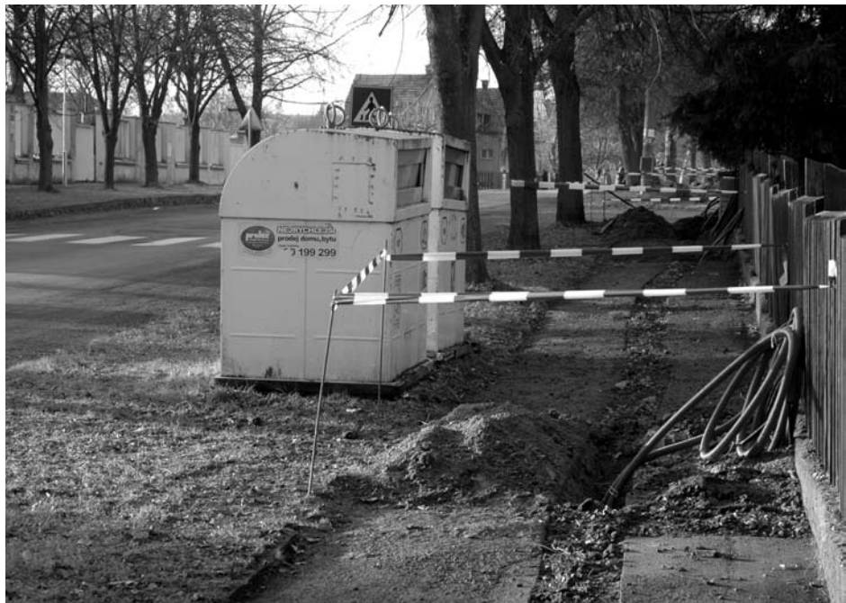
V Manětínské ulici probíhá v těchto dnech pokládka kabelů, které nabrzdí dosavadní venkovní rozvody elektřiny. Město ukládá současně do výkopů i přípojky pro nové veřejné osvětlení, které bude zřízeno po obou stranách ulice. Foto Karel ROM
