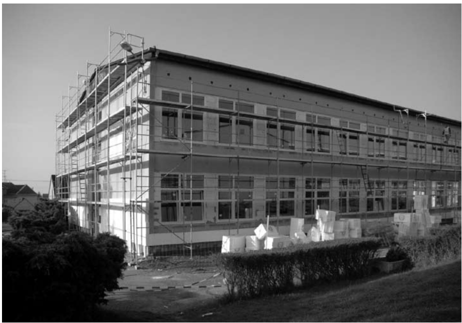
Pracovníci stavební firmy, která provádí zateplení objektů základní školy, již vyměnili velkou část oken, současně lepí izolační vrstvy na fasády. Město připravuje podání žádosti o dotaci na zateplení školní tělocvičny, které není součástí právě probíhající akce.
