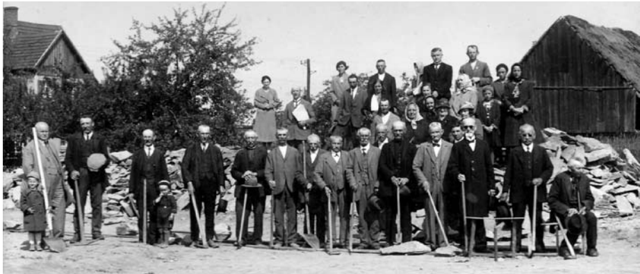
Členové sboru při přípravě místa stavby dne 24.5. 1934
