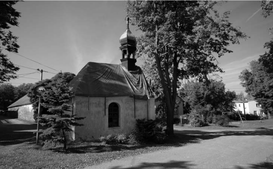
Novou střechu dostává v těchto dnech návesní kaple v Bukovině. Foto Karel ROM
