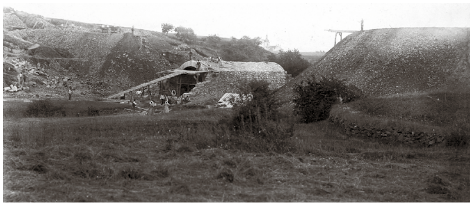
Stavba tratě mezi Kralovicemi a Mariánskou Týnicí. Zdroj kronika železniční stanice.
