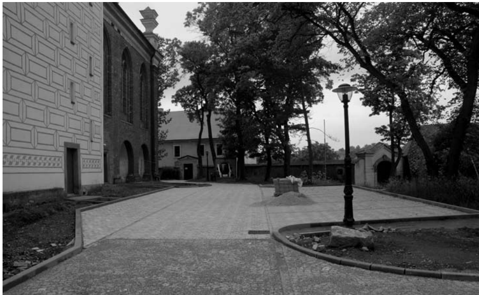
Současný stav rekonstrukčních prací u farního kostela již poskytuje celkem jasnou představu o konečné podobě historicky cenného prostoru. Foto Karel ROM
