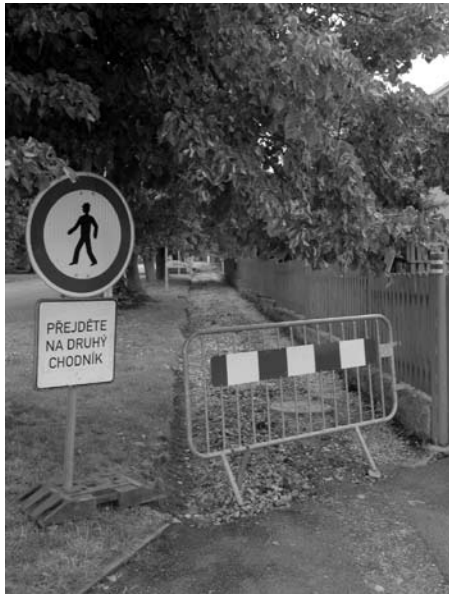
V Manětínské ulici zahájila firma JIPS rekonstrukci chodníku. Foto Karel ROM
