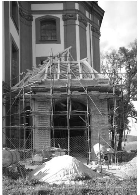
V Mariánské Týnici pokračuje dostavba kaple přiléhající ke kostelu Zvěstování Panny Marie. Foto Karel ROM
