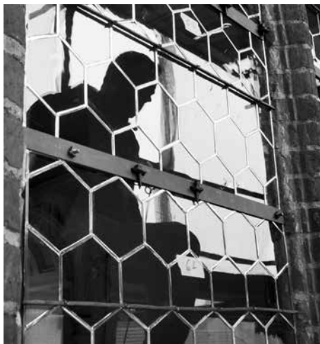
Restaurování vitrážových oken na kostele sv. Petra a Pavla. Foto T. Soukup
