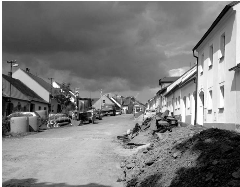
Dlouho připravovaná rekonstrukce ulice Petra Bezruče byla zahájena. V současné době zde probíhá oprava kanalizace a vodovodního řadu, které provádí firma OMEGA. Poté započne firma EURO-VIA s opravou silnice a chodníků. Foto Karel ROM
