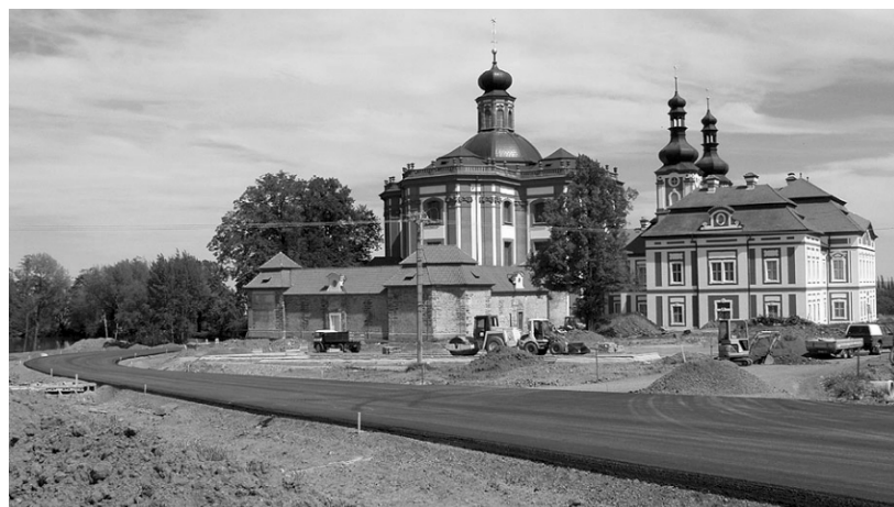
V Mariánské Týnici rychle pokračuje výstavba nového parkoviště. Přeložka silnice je již dokončena včetně povrchu. Vše má být hotovo během srpna letošního roku a dosavadní průběh prací nasvědčuje, že termín bude dodržen.
