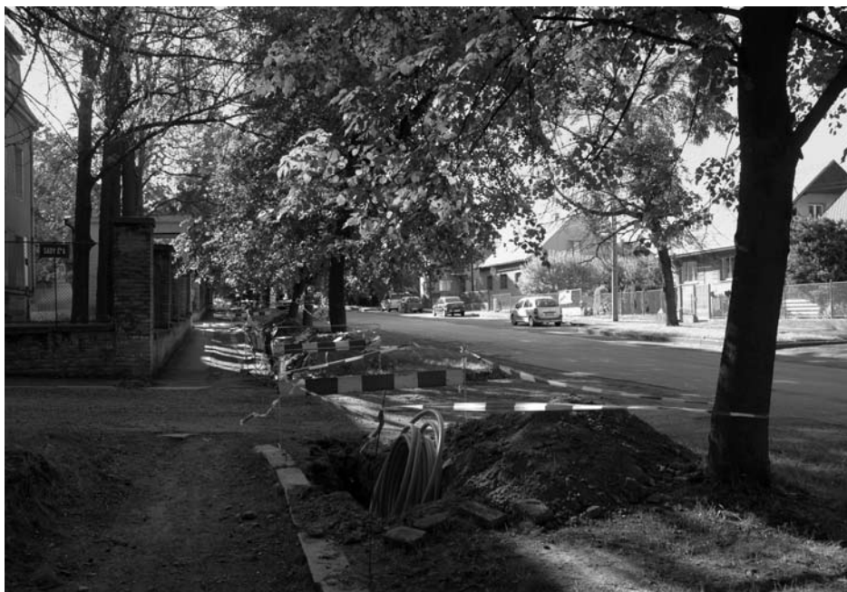
V Manětínské ulici byl uložen optický kabel kamerového systému a současně i rozvod elektriny pro rozšíření veřejného osvětlení v této části města. Foto Karel ROM
