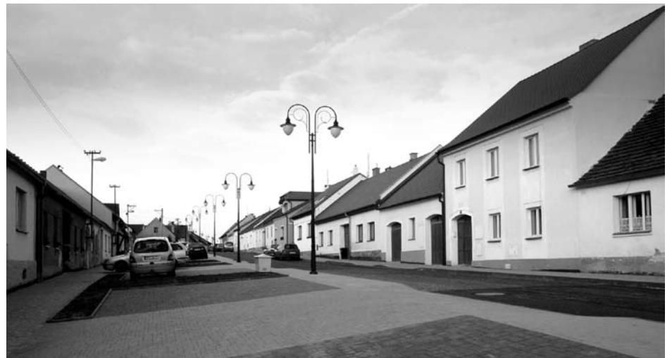
V ulici Petra Bezruče byly položeny na vozovku povrchy z balené asfaltové směsi a vydlážděny zpo- malovací prahy a rekonstrukce je tak definitivně ukončena. Foto Karel ROM
