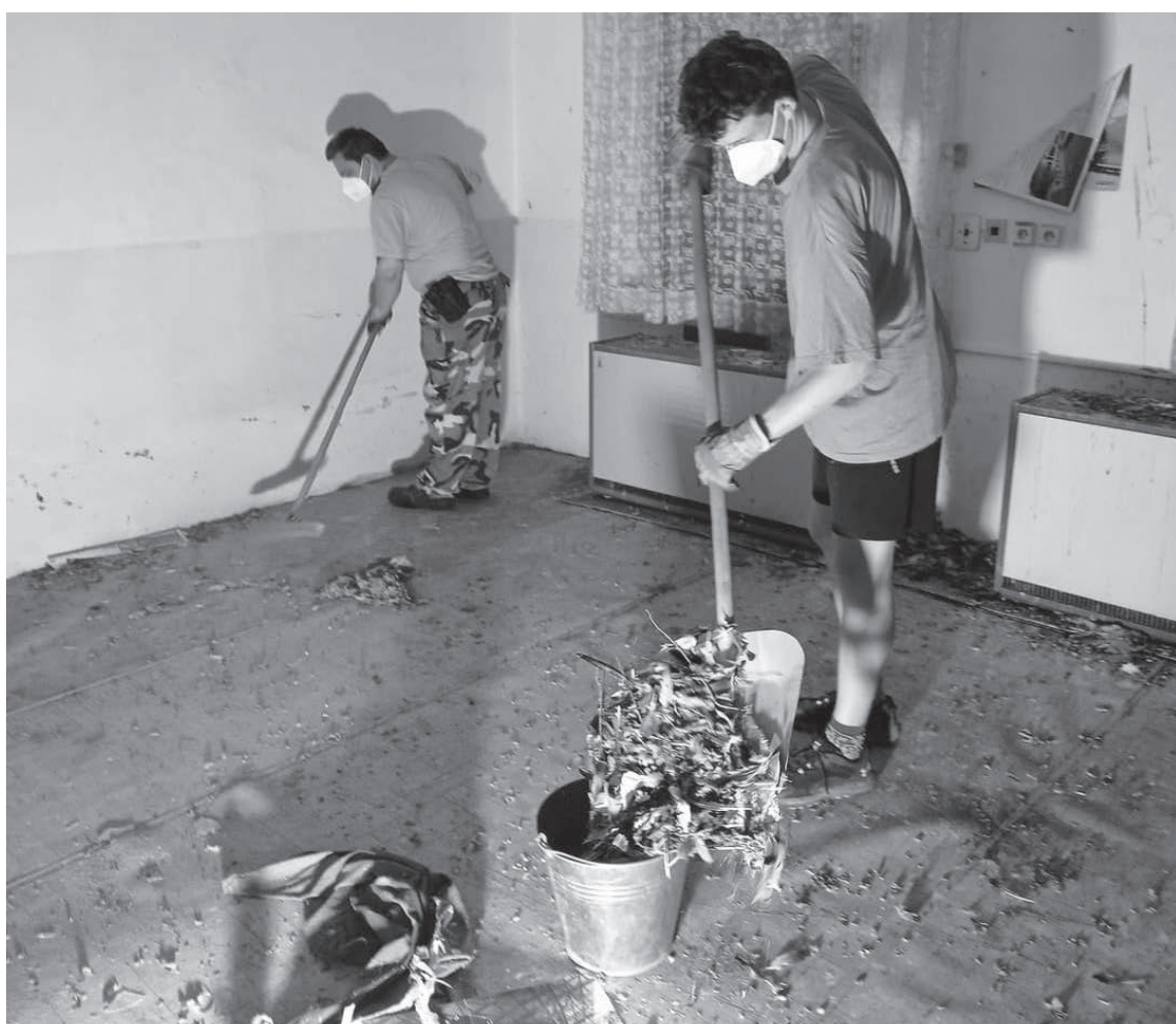
V sobotu 12. srpna proběhla brigáda na vyklizení vnitřních prostor nádražní budovy v Kralovicích (viz foto). Správa železnic budovu v červnu předala městu a úklid dvacet let chátrající stavby je prvním krokem k její renovaci. Foto V. Kopta
