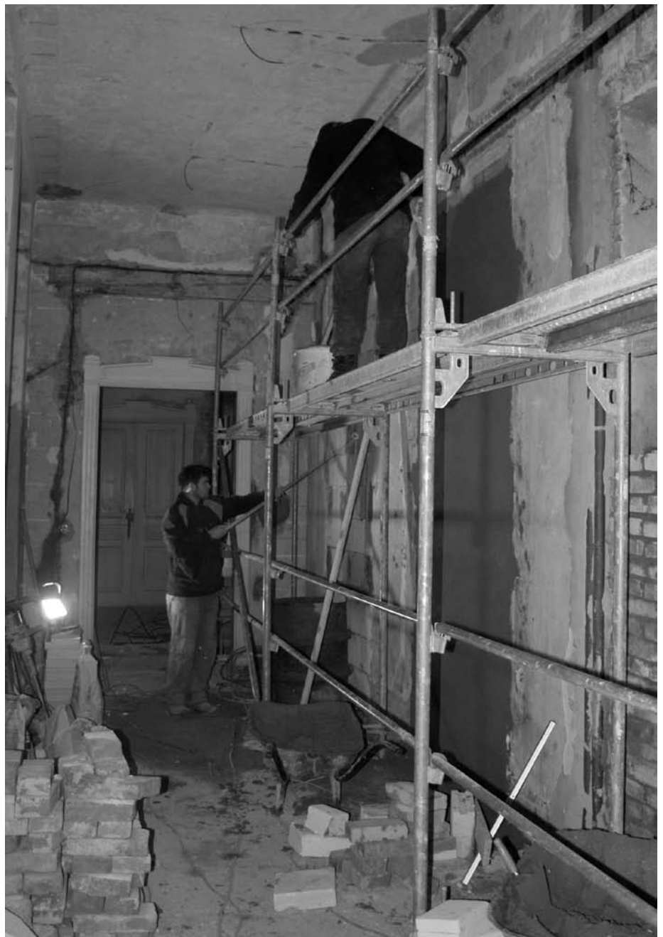
Interiér městské knihovny by dnes nepoznali ani její nejvěrnější čtenáři. Práce však rychle pokračují – přístavba nové části je již v hrubé stavbě hotova a naplno se pracuje i na rekonstrukci původních prostor. Foto Karel ROM
