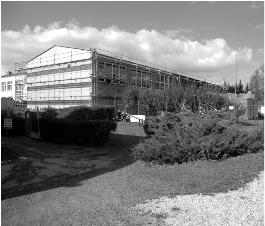
V areálu základní školy probíhá v současné době zateplování budovy tělocvičny (bliže na straně 1)
