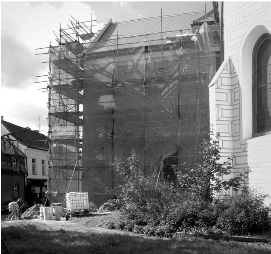
Zastupitelstvo města na svém zasedání 17. září mimo jiné schválilo i finanční příspěvek pro Římskokatolickou farnost Kralovice ve výši 70 000 Kč na spolufinancování pokračující opravy a restaurování sgrafitové venkovní omítky kostela sv. Petra a Pavla v Kralovicích. Foto Karel ROM
