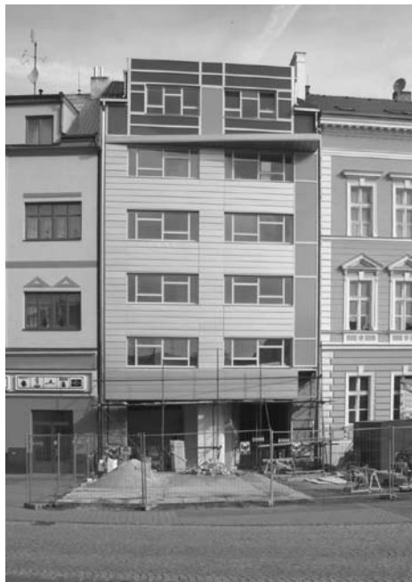
Novostavba domova mládeže Střední školy Kralovice. Foto Karel ROM
