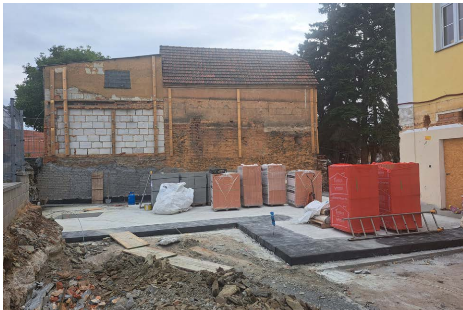
Staveniště nové vznikajících dílen pro základní školu praktickou. Foto K. Popel
