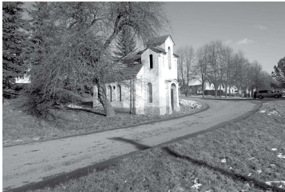
Město připravuje opravu návesní kaple v Hradecku. Po nedávné rekonstrukci kaple v Bukovině by se tak měla dočkat renovace další z drobných památek
