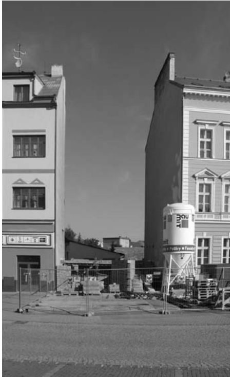
V léta nezastavěné proluce uprostřed kralovického náměstí již vyrůstá budova, v níž budou ubytováni žáci a studenti střední odborné školy. Foto Karel ROM
