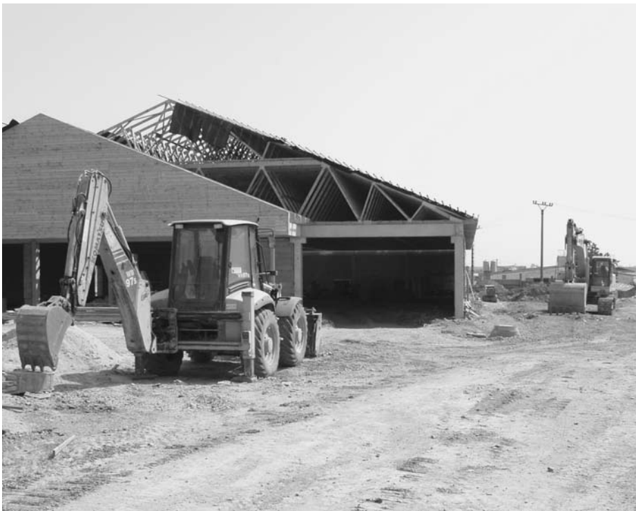
Po dlouhých počátečních průtazích teď nová diskontní prodejna obchodního potravinářského řetězce Penny Market Na Výsluní doslova roste před očima. Musí být ještě přemístěna stávající trafostanice a součástí stavby bude i vybudování odbočovacíh pruhů z hlavní silnice v obou směrech. Stále platí, že má být hotovo během léta. Foto Karel Rom
