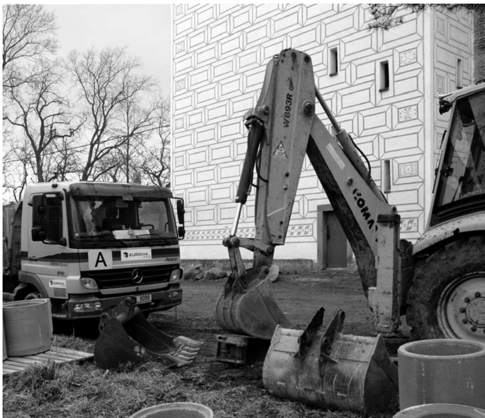
Firma EUROVIA CS zahájila rekonstrukci kanalizace úpravy okolí farního kostela sv. Petra a Pavla (podrobnou informaci jsme přinesli v minulém čísle). Oproti původním předpokladům bude nutné do první, tedy letošní fáze prací zařadit i rekonstrukci opěrné zdičky kolem parku, která je mělce založena a novou silnici by nebylo možné v těchto místech provést. Bude proto rozebrána a znovu postavena, což si vyžádá zvýšení nákladů asi o 400 000 Kč. Z týchž důvodů bylo nutno odstranit i tři stromy v blízkosti zdičky. Mimo navěšení kostela bude v této etapě zřízena i část veřejného osvětlení – vyšší stožáry, které budou v příštím roce ještě doplněny o nízké stožáry podobně, jako je tomu v jiných nově rekonstruovaných částech města.
