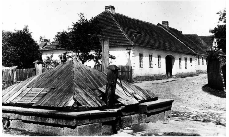
Dlouhá ulice s kašnou, čp. 221 a čp. 222
