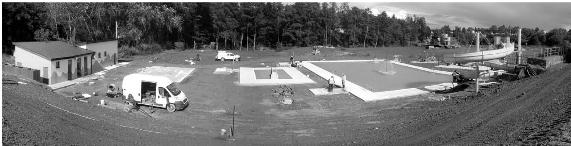
Celkový pohled na již téměř dokončený sportovní a rekreační areál s novým koupalištěm. Foto Jiří BEBR
