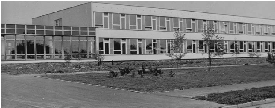
Objekty základní školy krátce po dokončení. Foto archiv ZŠ
